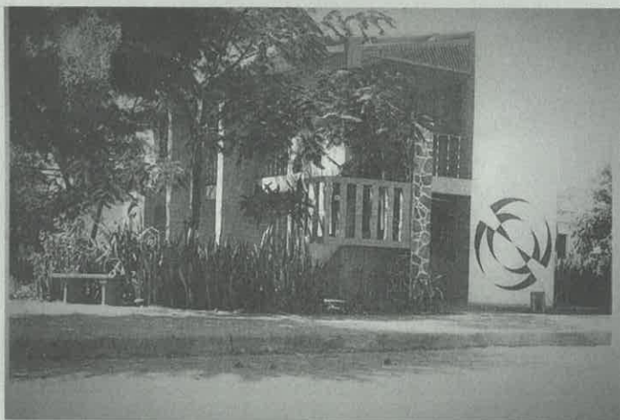
"Abrigo" na praça Isaías Coelho, onde "a juventude dançava iê-iê-iê ao som de uma radiola". Foi construído por Ney Moura Fé na sua primeira administração. Demolido para dar lugar ao novo "abrigo" na segunda administração de Heli Moura Fé.
