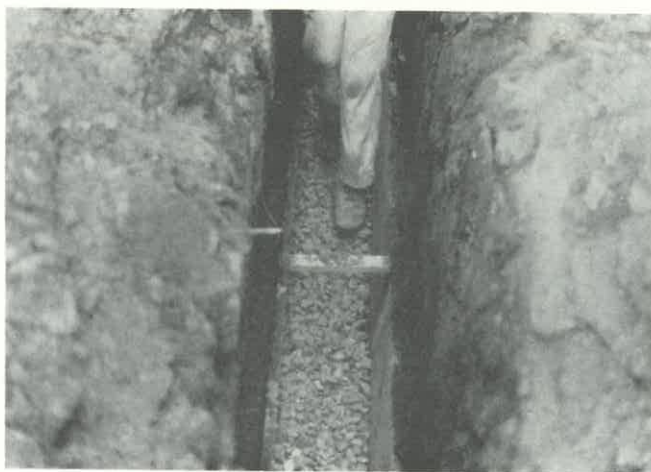
Fig. 11 - Execução de dreno descontinuo
