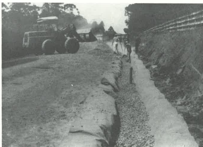
Fig. 12 - Execução de um dos drenos com Bidim
