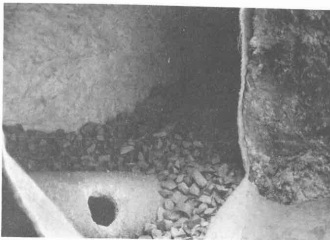
Fig. 15 - Abertura do dreno e tubo poroso
