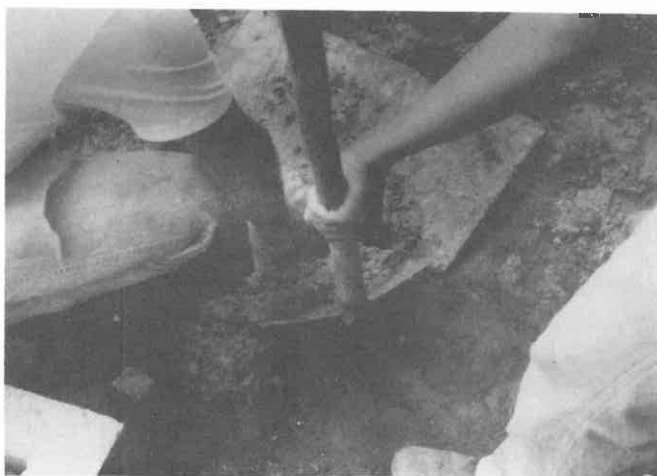
Fig. 6 - Preenchimento, com areia, do espaço entre o tubo de PVC perfurado e revestido com Bidim e a parede do furo de sondagem
