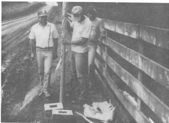
Fig. 5 - Colocação do tubo de PVC perfurado e revestido com Bidim no interior do furo de sondagem
