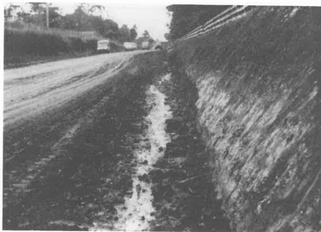
Fig. 2 - Aspecto do Talude e do pé do corte
