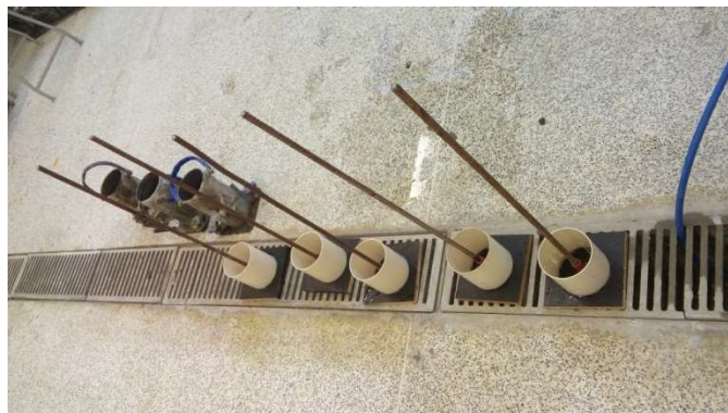
Figura 4 - Moldes montados antes da concretagem Fonte: Autora, 2016.
