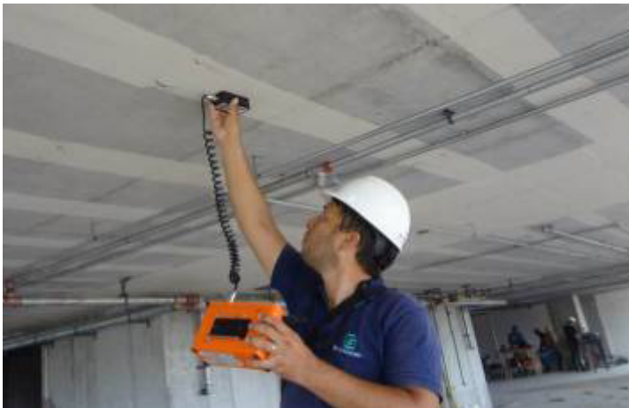
Figura 3 – Ubicación de armaduras con detector electromagnético.
