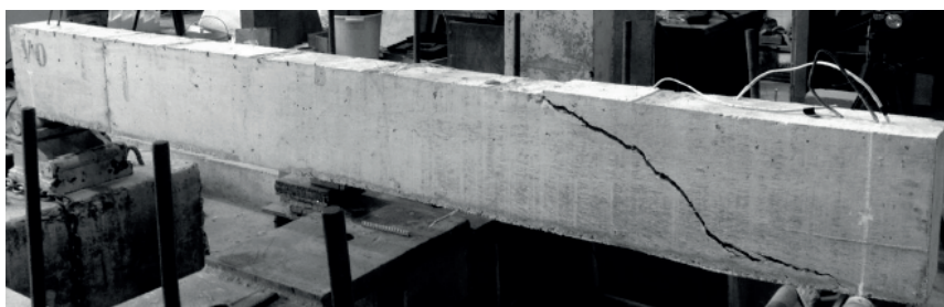
a) Mapeamento da fissura (GOMES, 2016).
