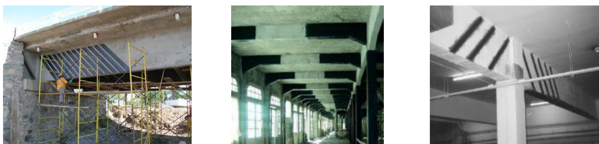
Figura 1 – Vigas Reforçadas ao Cisalhamento com PRFC.
