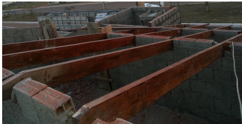
Figura 16 – Ripas de madeira apoiadas diretamente sobre a alvenaria cerâmica
