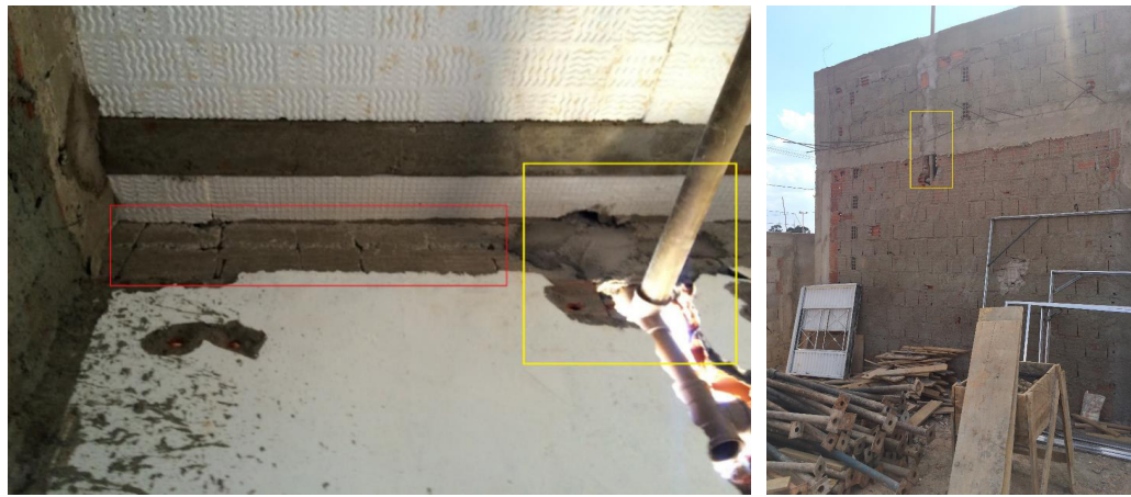
Figura 9 – a) Viga do banheiro com armadura exposta devido ao baixo cobrimento (vermelho) e passagem da tubulação internamente à residência (amarelo), b) Passagem da tubulação em viga sendo vista externamente à residência (amarelo)
