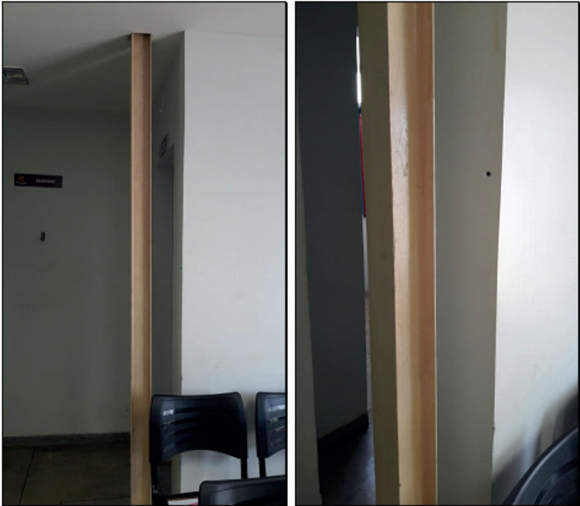
Figura 5 - Pilares e Vigas Metálicos.
