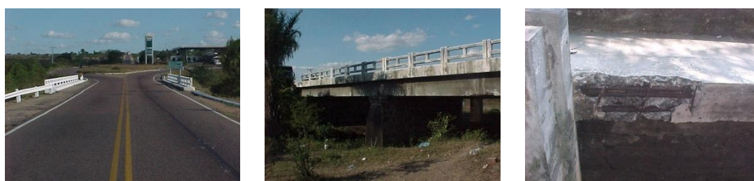
Figura 5.51 – Ponte s/ o Rio Pojuca, BR-116/BA, Km 420 – (1965) Condição de estabilidade: Sofrível - Condição de conservação: Boa/Reg
