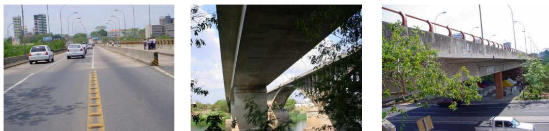
Figura 5.25 – Ponte sobre o Rio Poti, BR-343, Km 344, Teresina – PI, em condição de estabilidade boa (1978)
