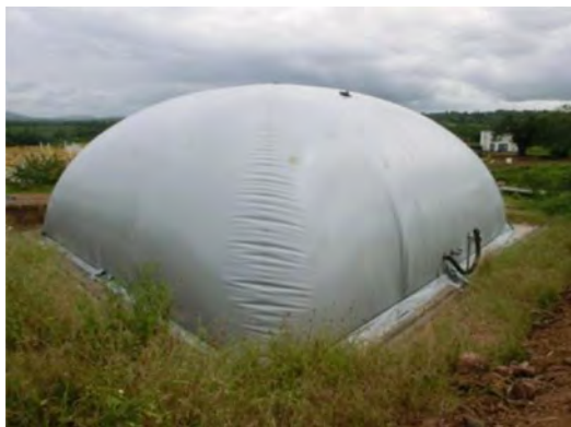
Figura 4 – Reservatório de biogás instalado na ETE Jacuípe 2
