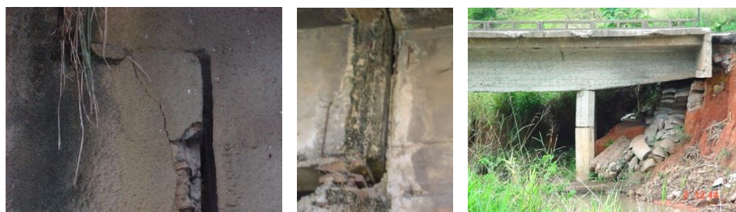
Figura 16 – Elementos problemáticos: dente Gerber, apoio e pilar Dente Gerber ponte s/ Rio Jequitinhonha, BR-101/BA, Km 663 (1965) Apoio da ponte s/ Rio Gravataí, BR-116/RS, Km 270 (1950) Pilar c/ desaprumo da ponte s/ Rio Preto - Norte, BR-101/ES, Km 30 (1958)
