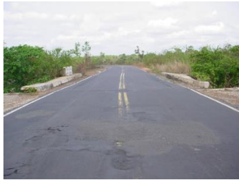
Figura 5 – Ponte sobre o Rio Raposo, BR-343, Km 294, Altos – PI, em condição de estabilidade sofrível (1938)
