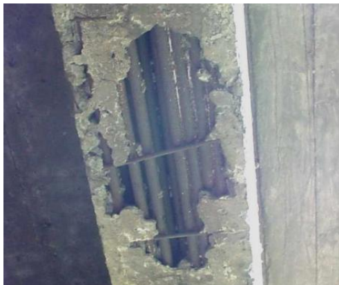
(c) Ponte em São Paulo – 48 anos
