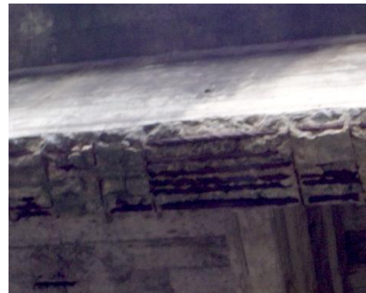
(d) Ponte no Rio Grande do Sul – 47 anos
