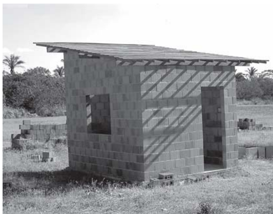
Figura 24 – Módulo executado com coberta de telha de cimento-amianto
