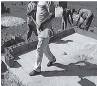
Figura 15 – Marcação da primeira fiada
