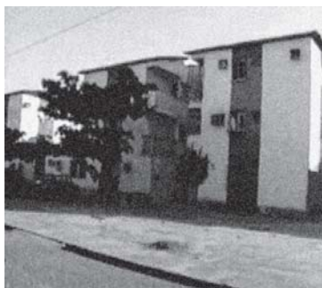
Figura 1 – Vista de edificação construída do Habitacional Morada Nova - Conj. Habitacional Morada Nova
