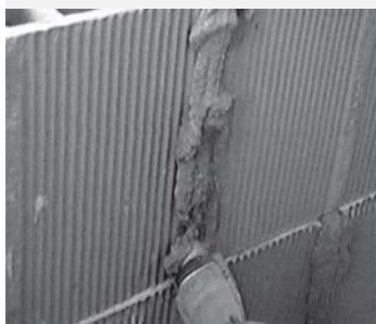
Figura 20 – Preenchimento das juntas verticais com bisnaga
