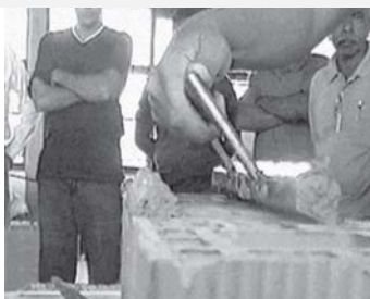
Figura 17 – Aplicação de argamassa com meia-cana
