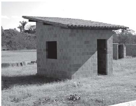
Figura 23 – Módulo executado com coberta de telha cerâmica
